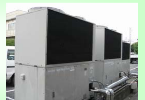
茂原鉱業所のガスヒートポンプ式空調
