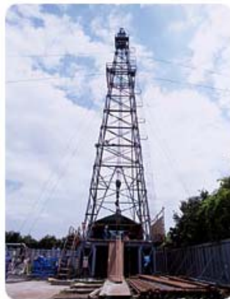
ガス井掘さく用のやぐら
